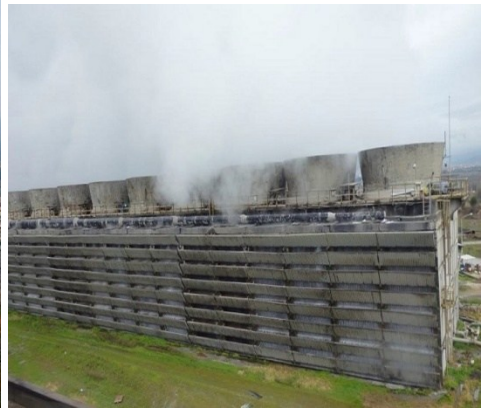
Sağda Yatağan kömür santralindeki soğutma kuleleri sistemi
