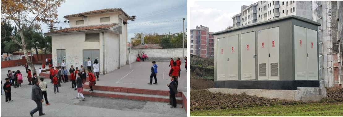
Resim 3, 4: Okul bahçesindeki trafo çevresinde oynayan çocuklar ve yüksek binaların önüne kurulmuş trafolar
