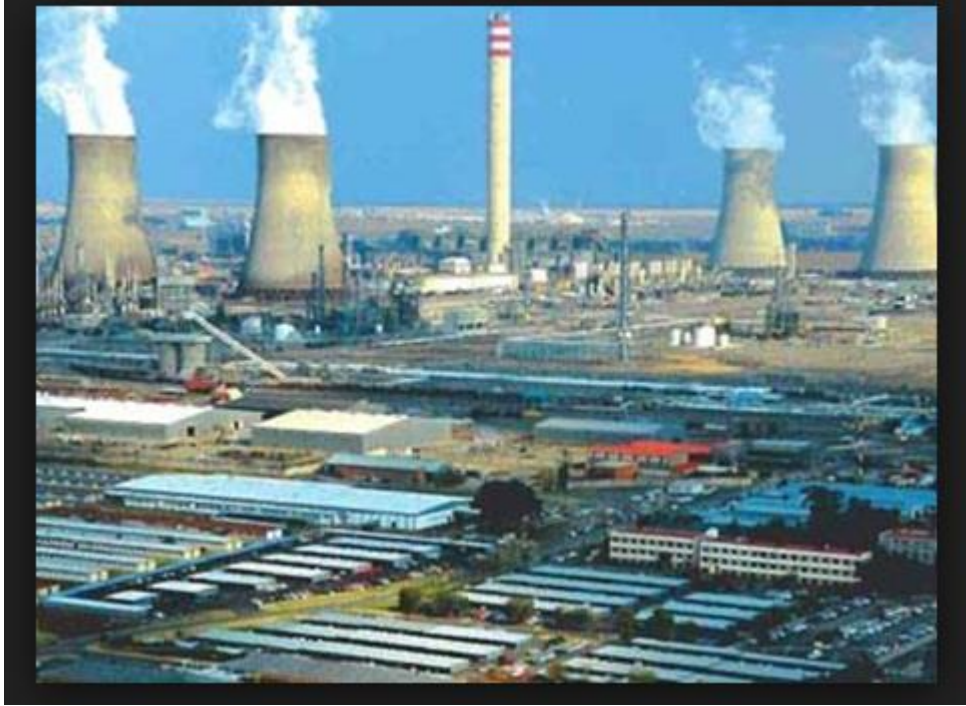
Şekil 2.6. Sasol tesisi- G.Afrika
